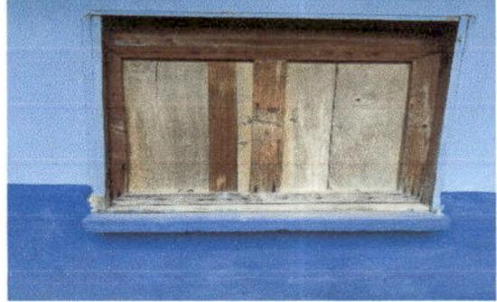
Foto 2: sustitucion de ventana de madera por metal, mas vidrio
